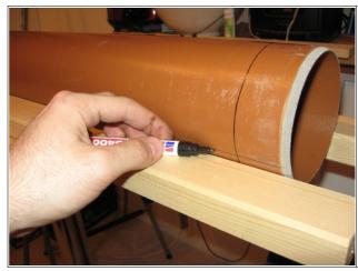
An einem Ende setzt man mit einer Schraubzwinge ein Stück Holz als Anschlag fest auf die Leisten. Wenn man nun das Rohr an diesen Anschlag schiebt, kann man ganz einfach die Mittellinie markieren indem man einen Stift 27,5cm vom Anschlag entfernt auf die Leiste legt und langsam das Rohr dreht.
